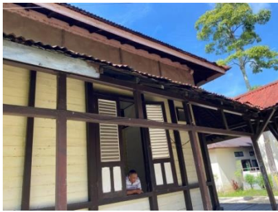
Bagian depan kanan terdapat 2 daun jendela variasi kayu panil dan jalusi yang membuka kearah keluar bangunan
