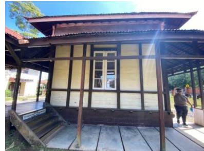
Bagian kiri bangunan terdapat jendela kaca dengan kusen kayu dan bagian kiri terdapat tangga berjumlah 4 anak tangga dan Lorong menuju tangga sudah melakukan perbaikan yaitu di lantainya semen
