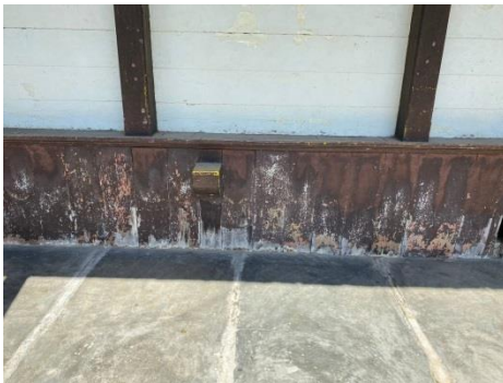
Bagian fasat kayu lantai bangunan masih menggunakan bangunan awal
