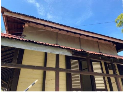
Dinding papan kayu horizontal di bagian luar bangunan dengan tiang dinding di bagian luar
