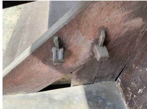
Fasat bagian anak tangga bagian depan masih menggunakan fasat bangunan dari awal
