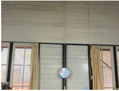
Foto dinding dalam bangunan bagian belakang belakang menggunakan kayu berbentuk vertical terdapat 4 daun jendela
