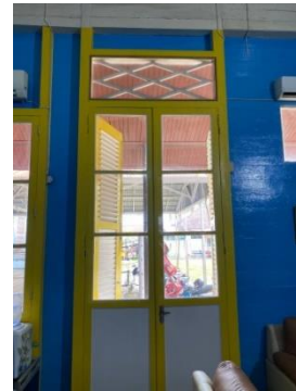
Foto daun pintu menuju luar ruangan memiliki pintu ganda material kayu dan kaca bening
