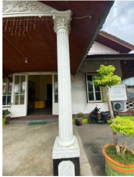
Foto Tiang Penyanggah depan berbentuk tiang bulat dengan penyanggah kotak di bagian bawah
