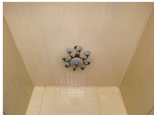
Foto Plafon atas bagian depan menggunakan kayu berbentuk vertikal
