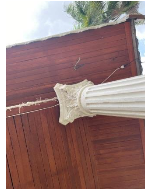
Bangunan tampak depan teras memili plafon kayu dengan penyanggah tiang
