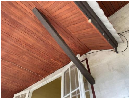
Bangunan tampak depan teras dengan plafon kayu dan terdapat tiang penyanggah di bagian ujung plafon
