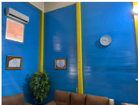
Foto dinding bagian kamar ruangan menggunakan kayu berbentuk vertikal
