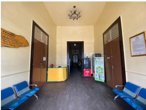
Foto ruangan bagian depan bagian lantai dan dinding menggunakan kayu
