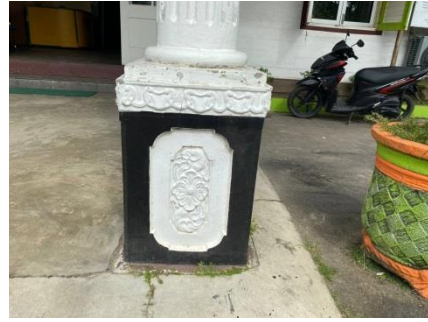
Foto Tiang Penyanggah depan dengan ornament lipsplank di bagian bawah
