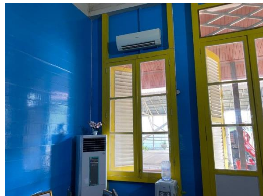
Foto tampak daun jendela bagian dalam kamar memiliki jendela ganda material kayu dan kaca bening
