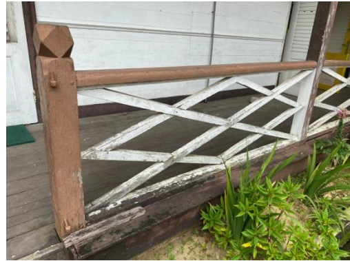
Foto pagar bagian kanan dengan bermotif diamon menggunakan banahan kayu
