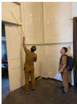
Dokumentasi tim PUPR melakukan pengukuran bangunan
