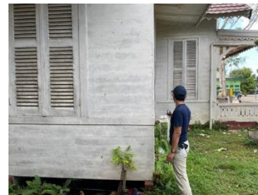
Dokumentasi tim bidang kebudayaan kota Singkawang melakukan pengukuran bangunan
